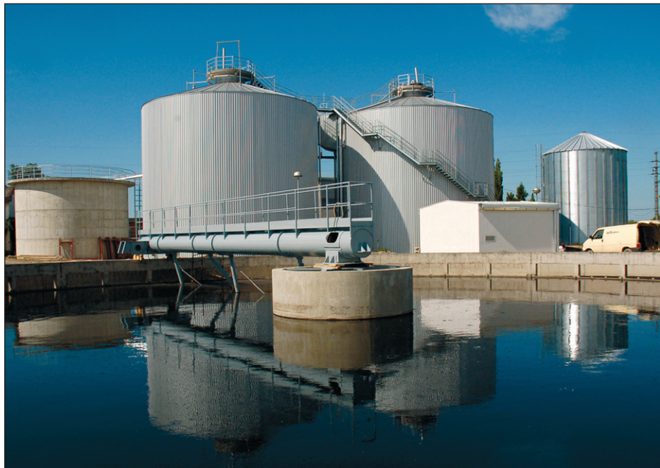
ЕКОЛОШКИ "Фабрика воде" која прерађује сирову воду у пијаћу.
